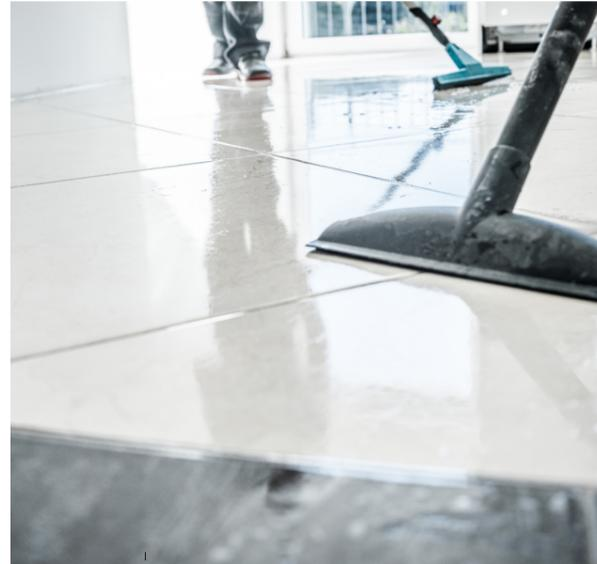
**2** Bei der Grundreinigung müssen alle trennenden Schichten mit maschineller Unterstützung entfernt und die Fläche hinterher mit klarem Wasser neutralisiert werden.
