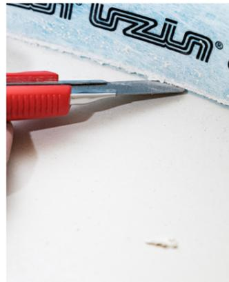
**5** Nach dem Erhärten und dem gegebenenfalls notwendigen Schleifen der Spachtelmasse kann der Randdämmstreifen flächenbündig abgeschnitten werden.
