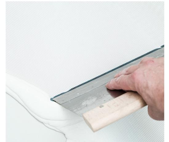
**8** Für die Verklebung wird ein auf den Belag abgestimmter Nassbett-Dispersionsklebstoff mit kurzer Abluftzeit verwendet. Es ist auf einen gleichmäßigen und flächendeckenden Auftrag zu achten, ohne die angezeichnete Markierung zu überschreiten.
