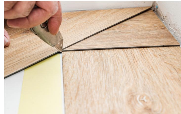
**7** Vor dem Verkleben werden die einzelnen Planken des Randfrieses ausgelegt, um die jeweiligen Eckplanken zu mitteln. Die Kopffugen der Anschlüsse in den Ecken werden im 45-Grad-Winkel auf Gehrung geschnitten (siehe Kasten).
