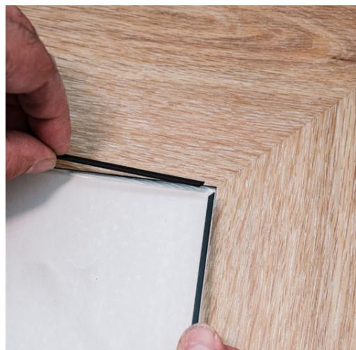
**3** Vor dem Spachteln des Untergrunds wird ein Randdämmstreifen an die Wand angebracht. Er sorgt für die mechanische Trennung zwischen Boden und Wand und verhindert so die Bildung von Schallbrücken.
