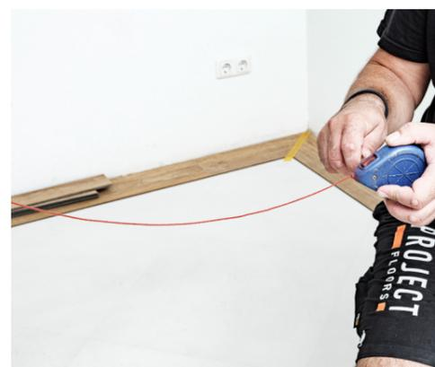
**6** Eine Fischgrätverlegung kann mit einem Randfries optisch aufgewertet werden, zudem gleicht dieser Winkelabweichungen der Wände aus. Vor der Verlegung wird dieser eingemessen und angezeichnet.
